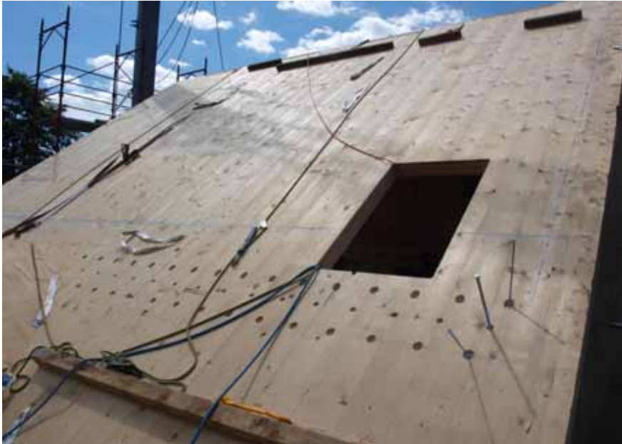
Banchina ed unioni copertura X-lam 140 mm
