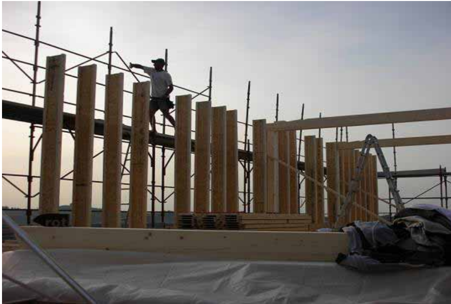
Fase di assemblamento profilati FIJ portanti
