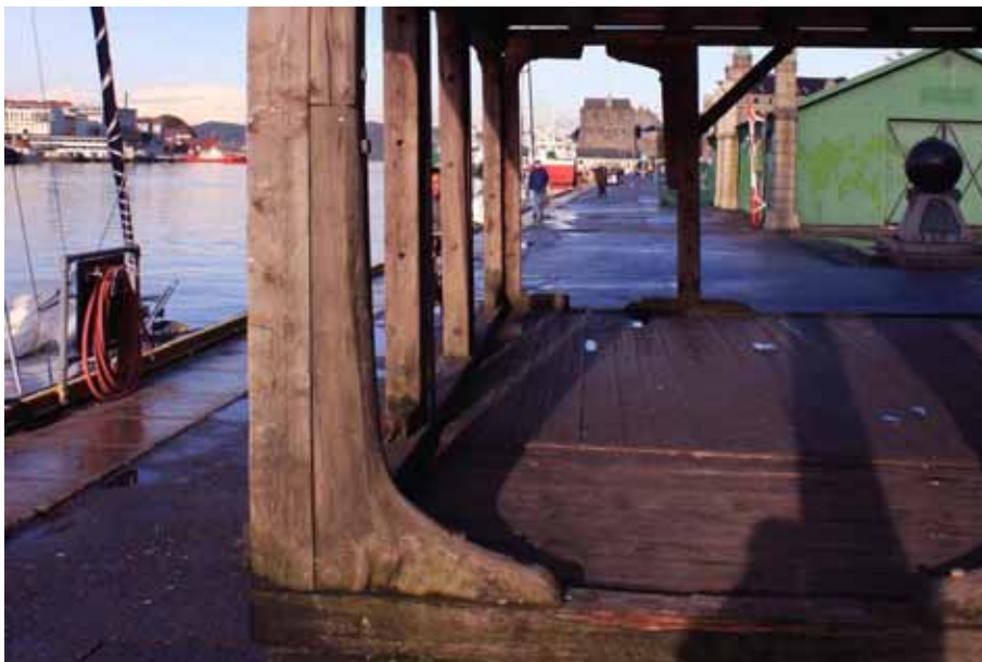
Sistema norvegese d'irrigidimento incastri
