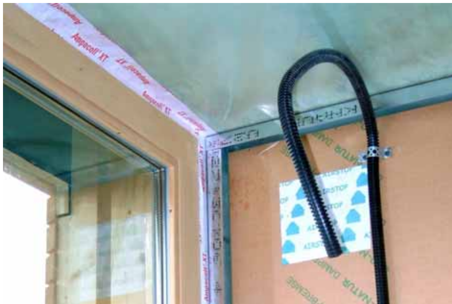
Sigillature per sistemi intelaiati in legno
