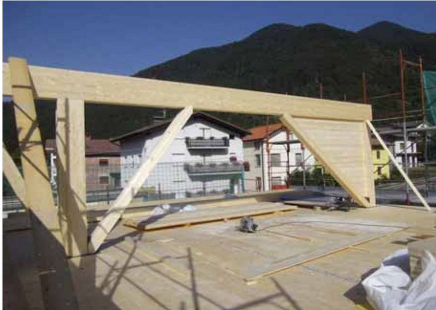
Telaio su primo solaio X-lam 200 mm
