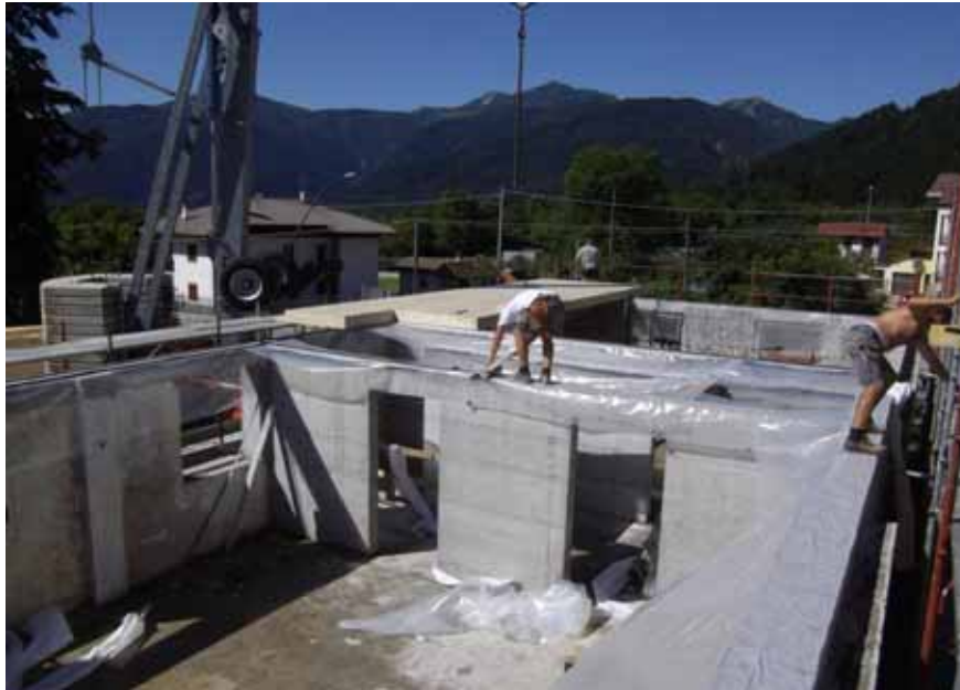
Cordolo di partenza con guarnizioni a tenuta
