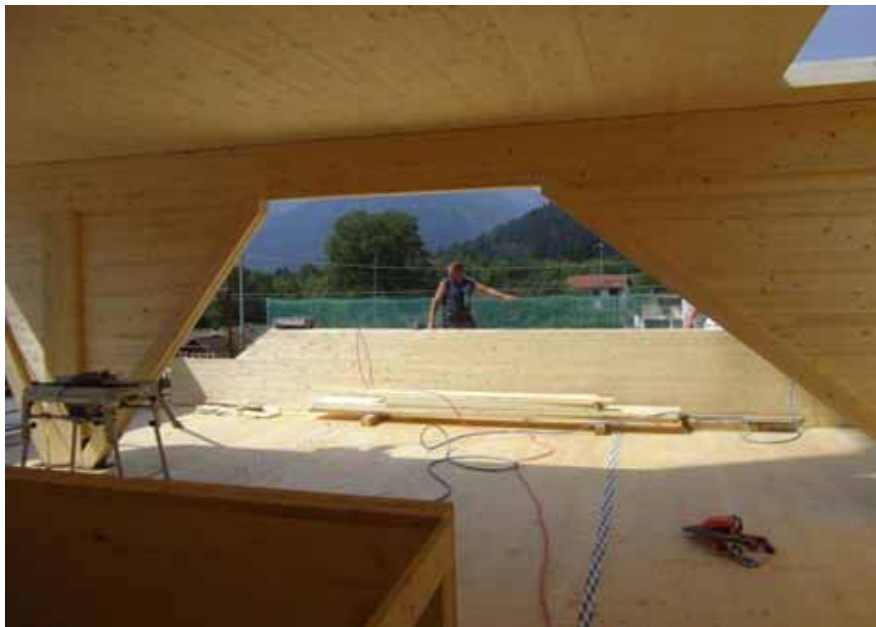
Telaio reggi secondo solaio X-lam 140 mm
